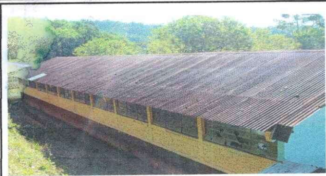
Foto1: SUSTITUCION DE LAMINAS, QUE ESTAN DESPERFECTAS.
